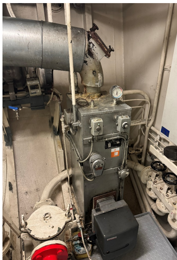
2. Tätningsmedel på oljepanna, maskinrum.
